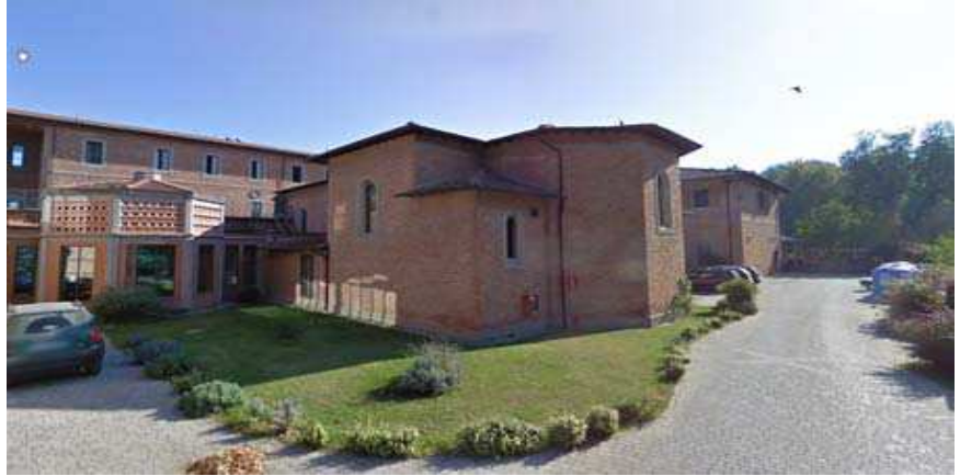
Strutture interne esistenti
