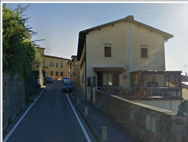
Prospetto lato Sud (vista via Cafaggio)
