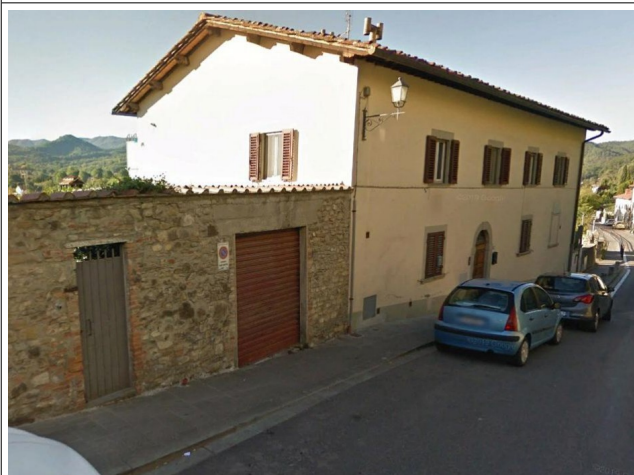
Prospetto lato Nord (vista via Cafaggio)
