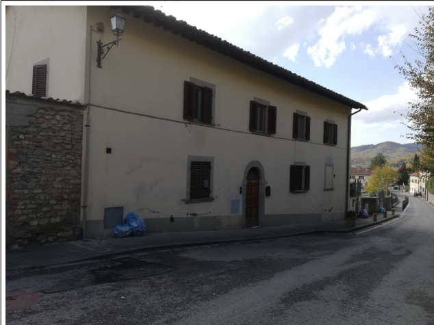
Prospetto (vista via Cafaggio)
