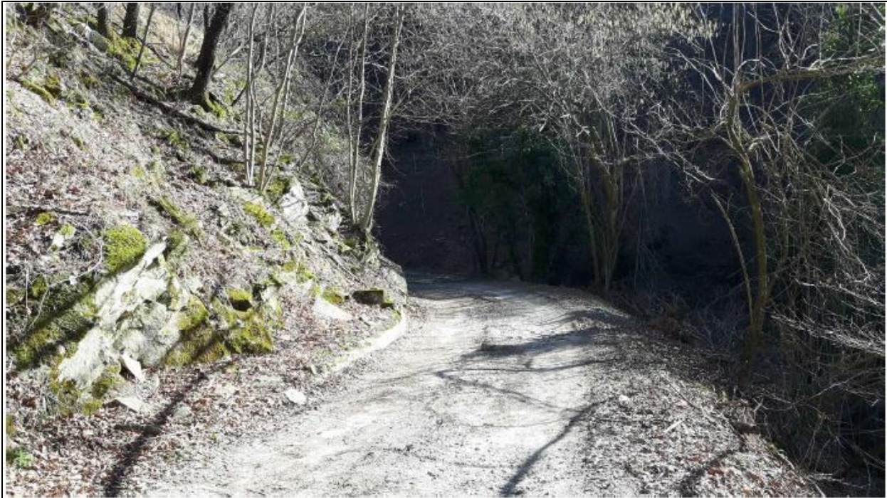
Figura 20. Vista della strada tra collettore Montolino e Collettore 1.
