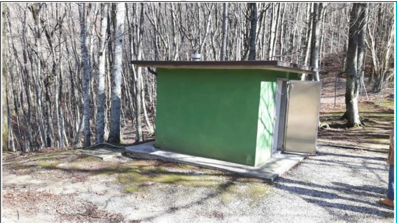
Figura 14. Vista esterna locale Pozzo Praterino attuale, da ampliare.
