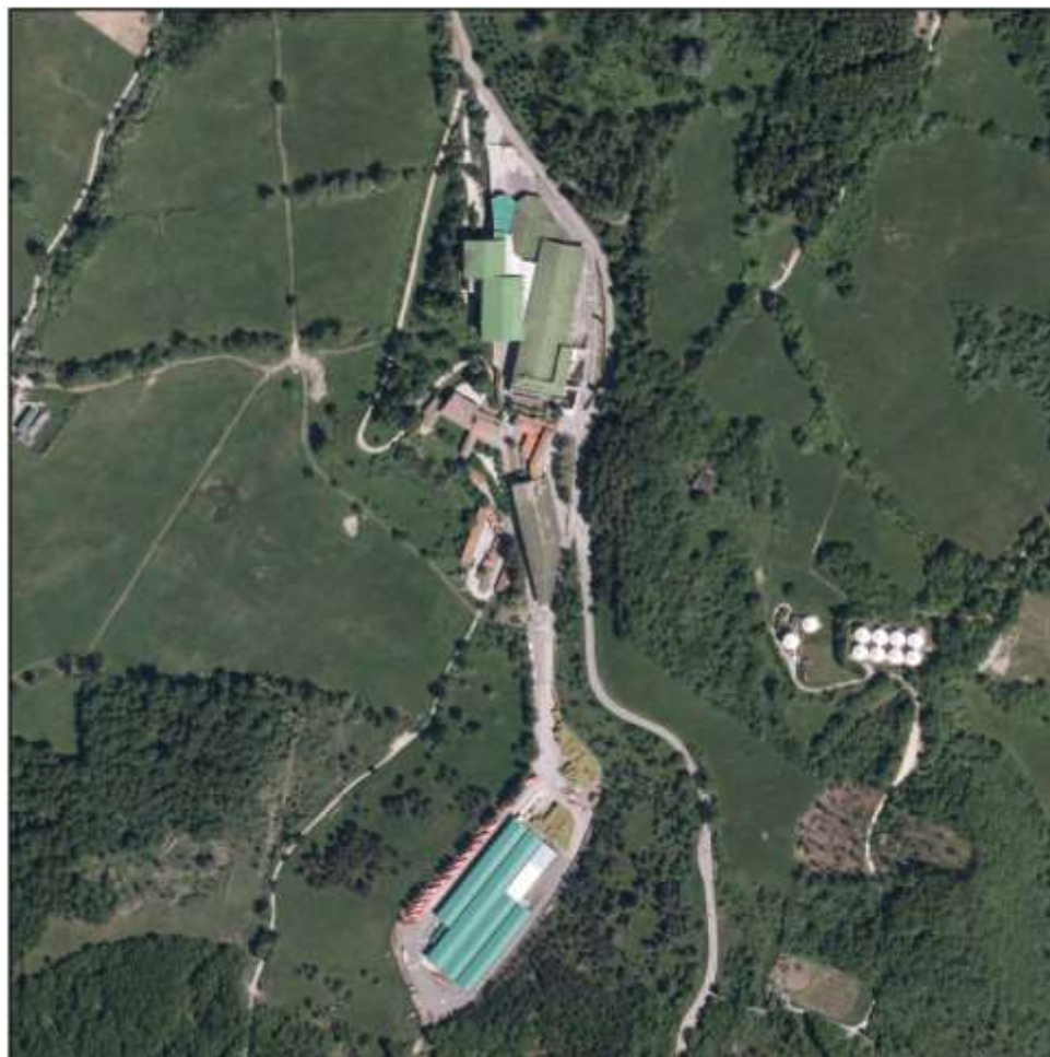
Fig. 5: Lo stato attuale dello stabilimento Panna (fotografia 2016)
